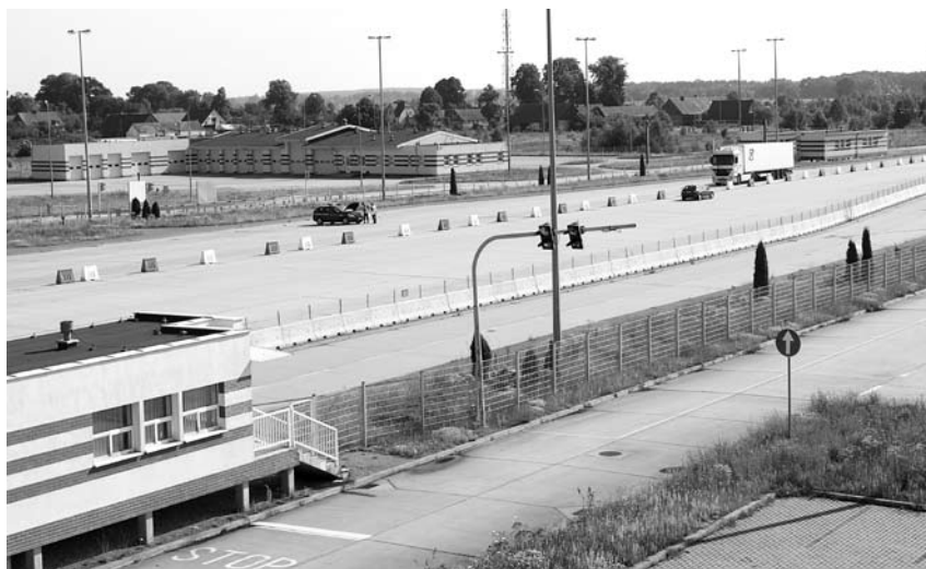
Terminal w Sękowicach
