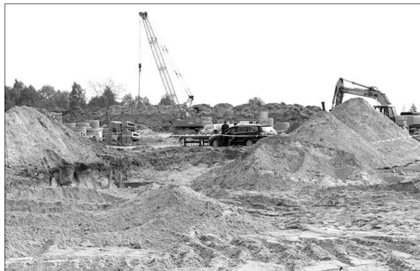
Na strefie trwają cały czas intensywne prace budowlane
