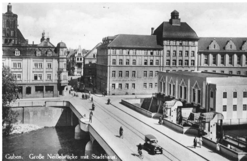
(1) Wschodnia część mostu
