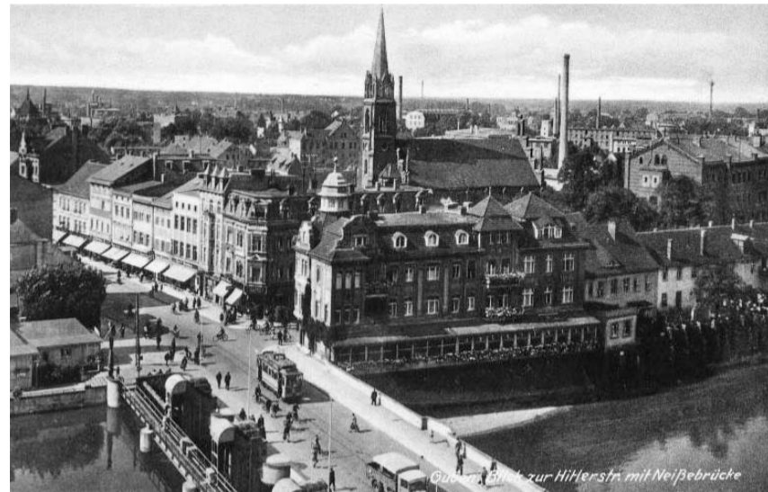
(2) Zachodnia część mostu
