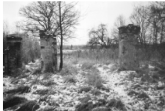
Pozostałości bramy wjazdowej do dawnego zamku w Budoradzu
